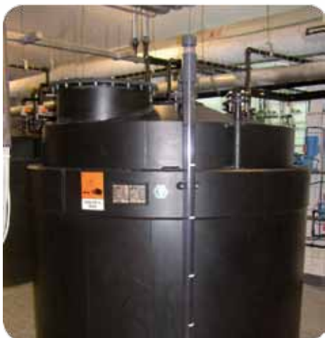
Zbiornik na media żrące z wanną wychwytyjącą - rysunek poglądowy.
