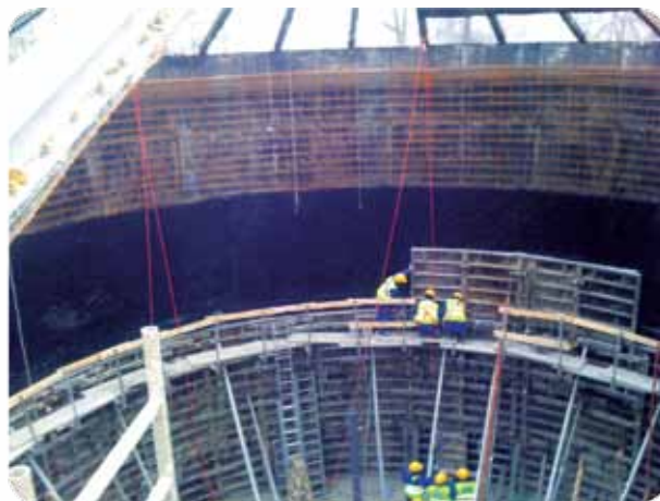
Montaż dachu stalowego z podwiązaniem płaszczą z PEHD
