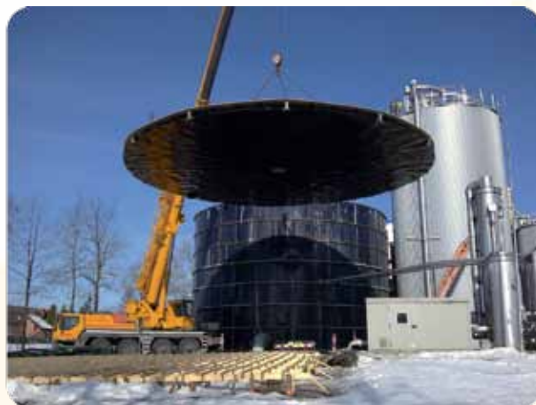
Montaż dachu stalowego z podwiązaniem płaszczą z PEHD
